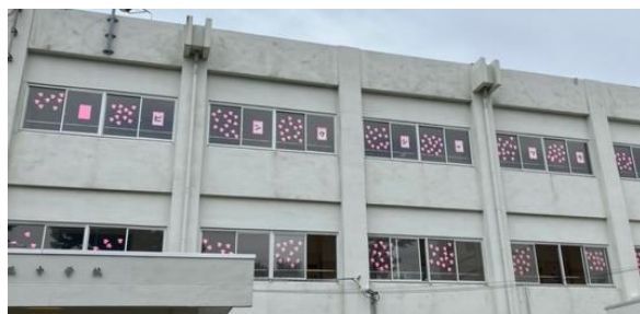
いじめ解消に向けたメッセージ 中庭から2号館を見た様子
